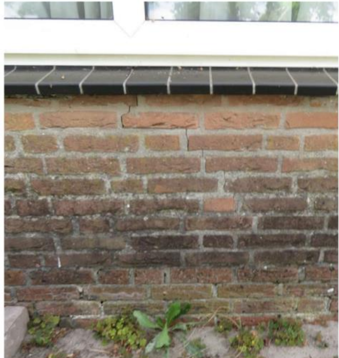
Foto 5.8: Scheur in borstwering onder het raam van
