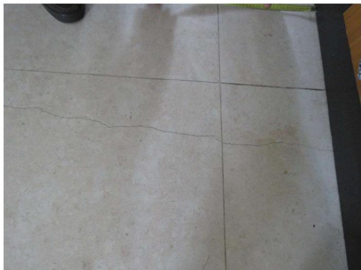
Foto 5.4: Scheur in tegelvloer in keuken (scheur 26).
